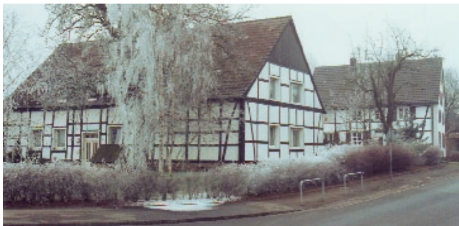
Das ursprüngliche Große Hilfshaus am historischen Hemmerder Hellweg/Ecke Hemmerder Dorfstraße, das bis zur Fertigstellung der heutigen B 1 im Jahre 1818 in Funktion war. Heute Wohnhaus. Foto: Heimatverein Hemmerde
